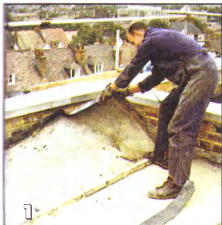
1 Старую кровлю полностью удаляют. Гвозди вытаскивают гвоздодером.
