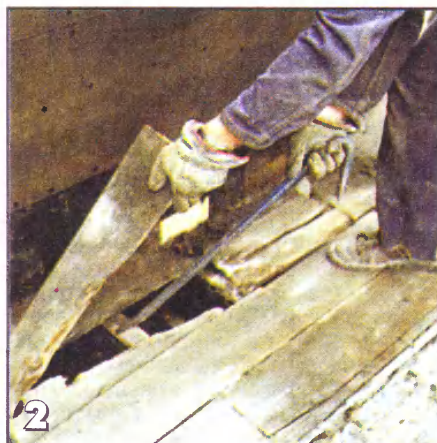
2 Все поврежденные или сгнившие деревянные детали следует заменить, будь то доски обрешетки или другие элементы конструкции.
