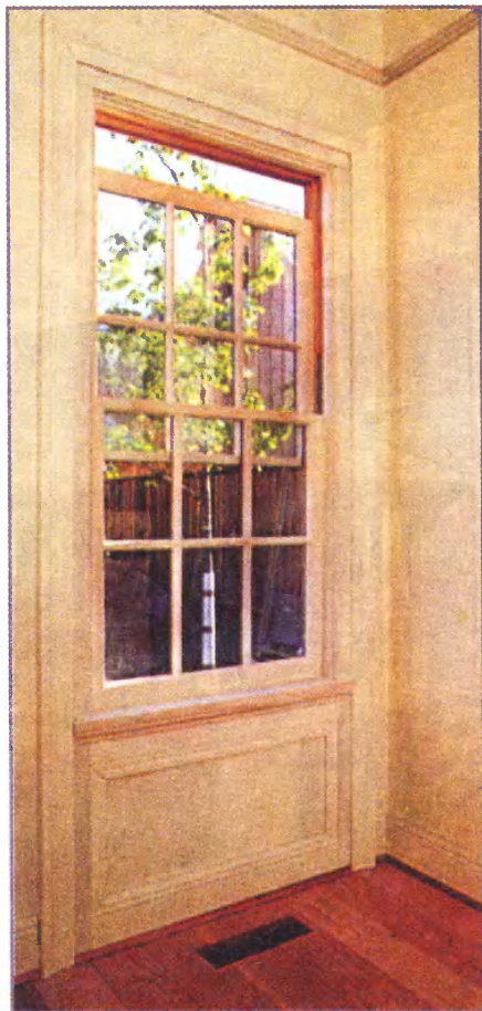
Внутренние двери и окна в домах Веппла окантованы окрашенными наличниками шириной 80 мм, установленными на подложки шириной 100 мм из ДВП средней плотности. В полу обеспечивается удобная стыковка панелей из ДВП и широких плинтусов.
