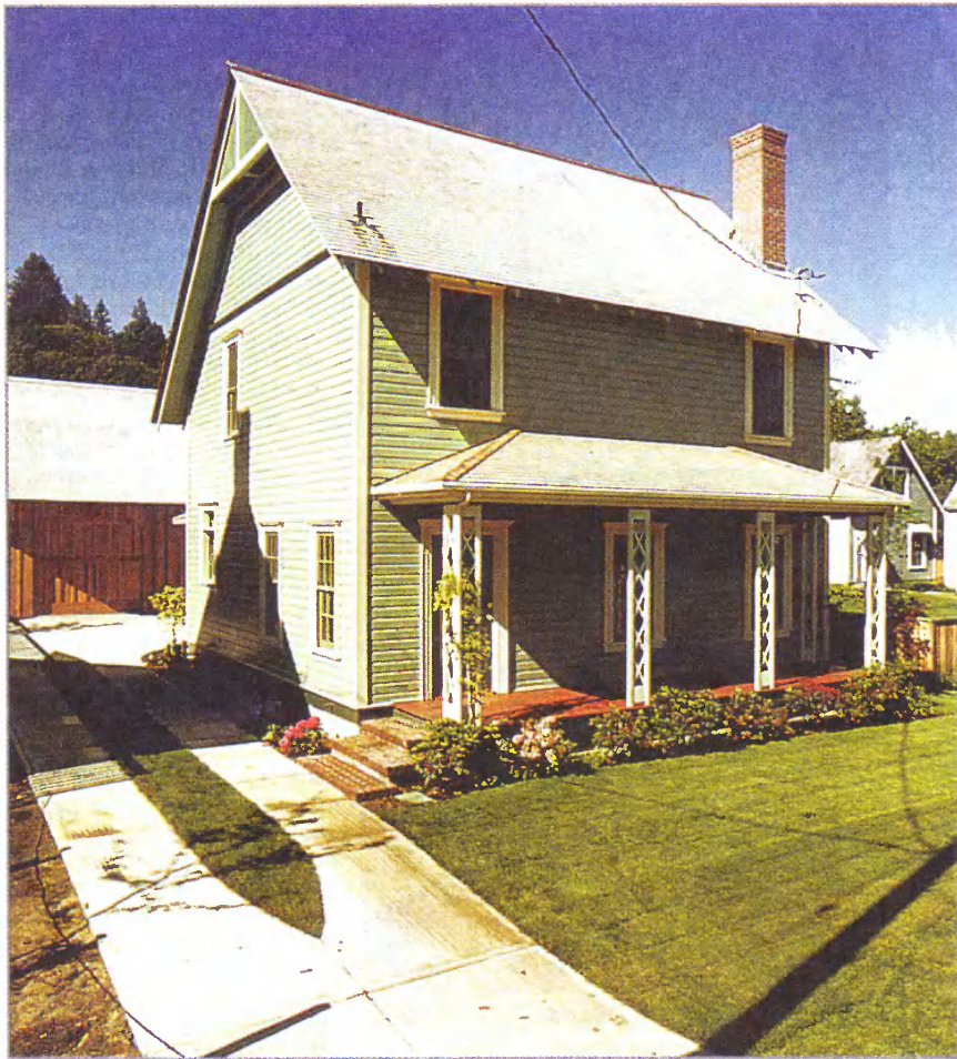
Веппл перестроил коттедж по образцу сохранившихся домов в Джексонвилле. Обшивку дома заменил горизонтальной чистой обшивкой из твердой ДВП, имитирующей древесину гонта. Кровлю перестелил кедровым гонтом, окна заменил на вертикальные, крыльцо перед входной дверью подвел под крышу.
