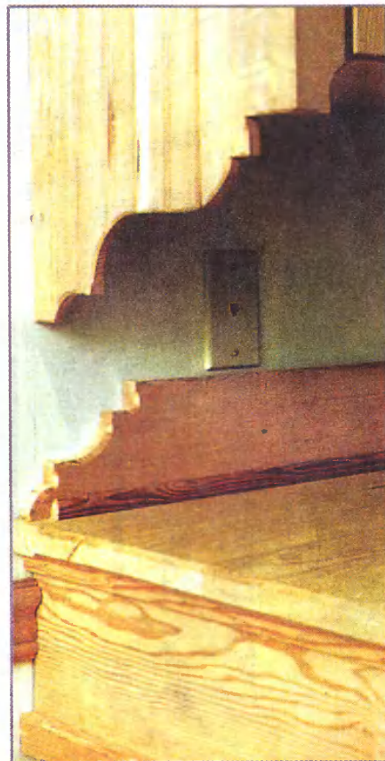
Резные брызговики из ели Веппл подогнал к задним сторонам карнизов. До установки он обработал их фрезой для фасок.
