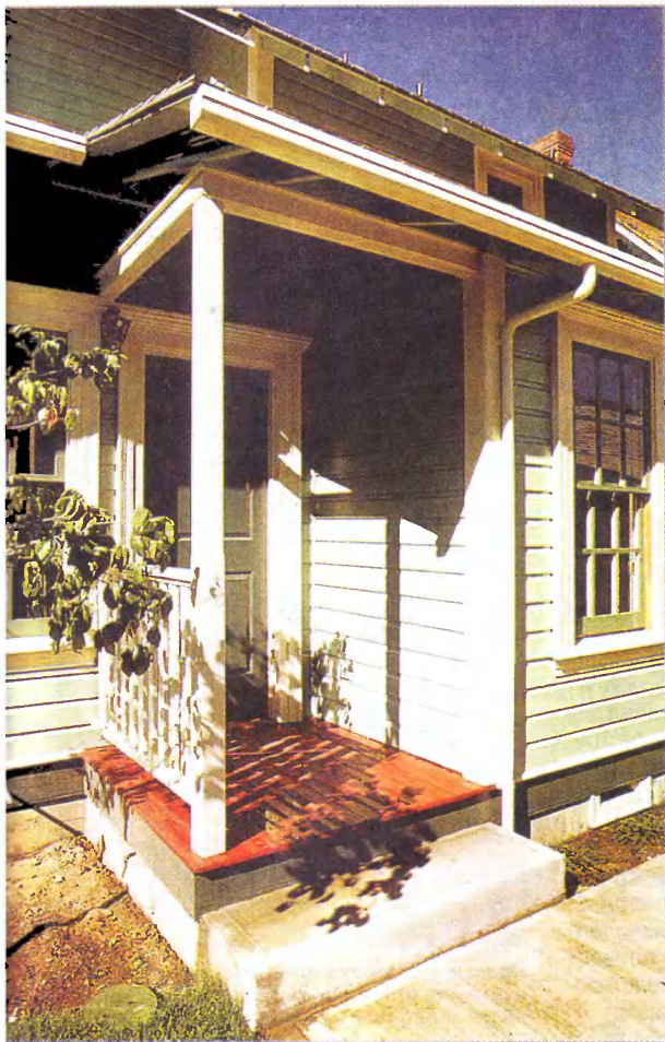
Фаски на ребрах стоек крыльца и досок, стыкующихся с ними, — еще одна дань традициям викторианского стиля. Темно-зеленый фартук, прикрытый сливным козырьком, тоже деталь викторианской эпохи. Обратите внимание, как устроены вентиляционные отверстия в фундаменте, обшитом отделочной доской.
