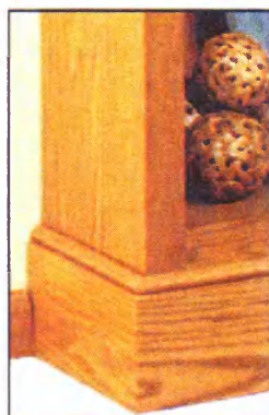
Рис. 15. Установка раскладок
